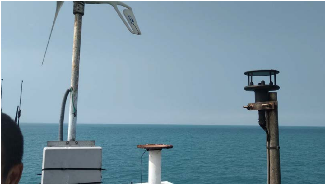
圖 2.2 臺北港風力測站照片
