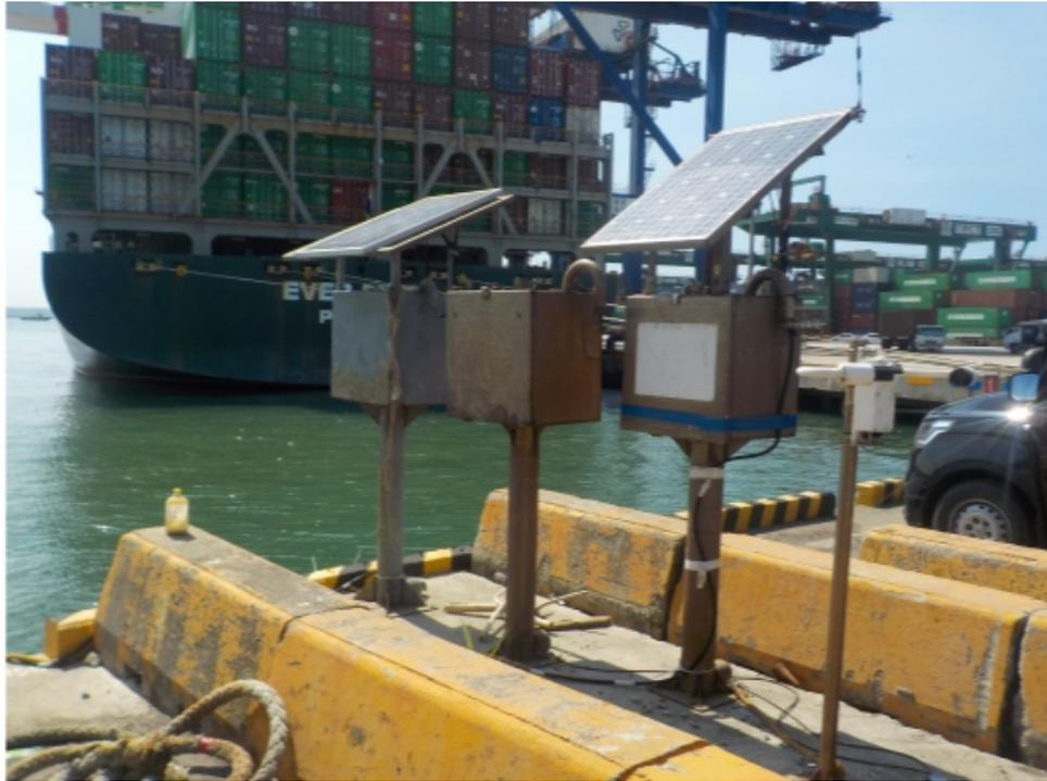
圖 2.2 臺北港潮汐測站岸上設備照片
