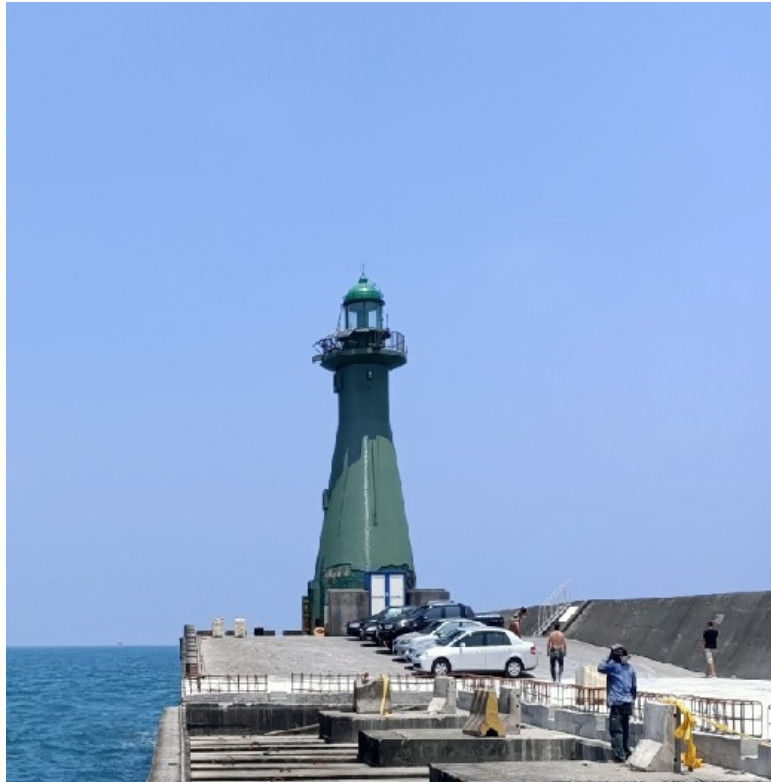
圖 9.2 臺中港波浪測站位置照片
