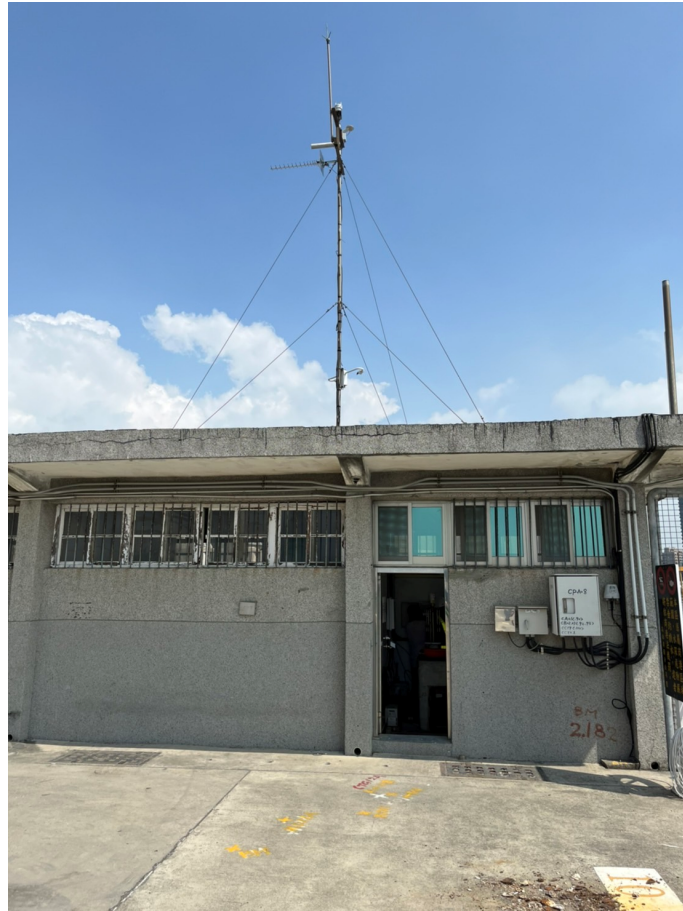
圖 6.2 高雄港風力觀測站現地照片
