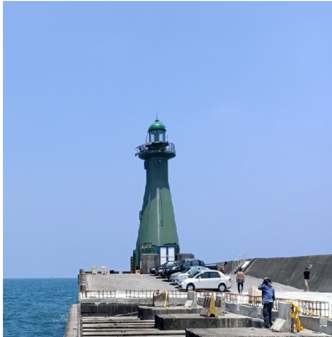
圖 9.2 臺中港海流觀測站現地照片
